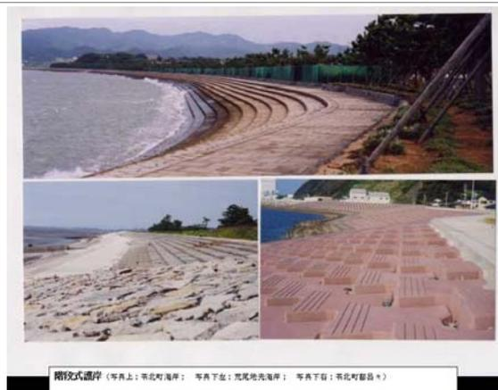
階段式護岸 (写真上：帯広町海岸； 写真下左：尻尾地先海岸； 写真下右：帯広町駅前\*)
